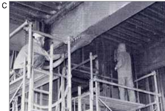
概ね3人1組の作業で吹きつけ者(左)、それを木製のコテで押え付ける者(右)、および調合綿を機械に投入する作業員からなっていました。どの作業も全身に石綿ばく露した可能性があります。
