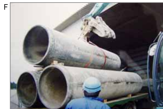
F 青石綿含有の使用済み水道管の現在の搬出風景。重量物ですので扱いが多少は手荒になることもあります。以前は現場で粉々に砕いて埋めており、その際に粉じんが舞ったと考えられます。
