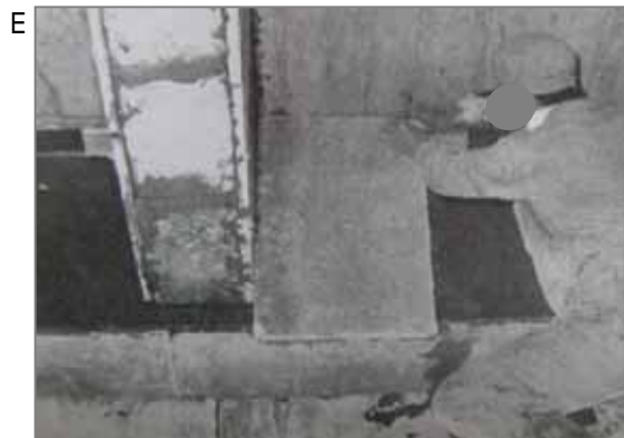
石綿耐火被覆板。工場にてトロ箱(のし餅をつくる箱のようなもの)に茶石綿、混和剤、固化剤などを入れ乾燥させて板にしたものを現場で取付けました。板を取り扱う際に表面の石綿がはがれることがありました。
