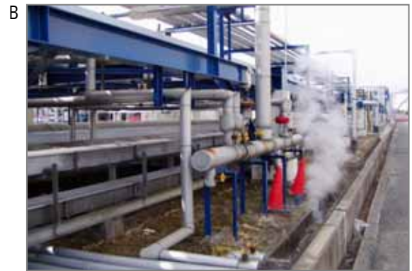
B 雨水のかかるような屋外では保温材の保護のために外周部に板金でカバーをします。屋内での配管保護は雨水の心配がないので布をゲートル状(包帯状)に巻きます。破損や劣化がなければ、石綿飛散の心配はありません。
