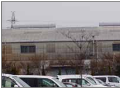
工場・倉庫などの屋根・壁
