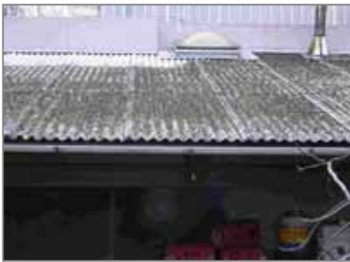
波型スレートの拡大写真
